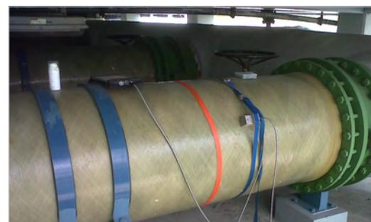
Transducteurs KATflow 230 et K0 installés sur une canalisation en fibre de verre à gros diamètres.
